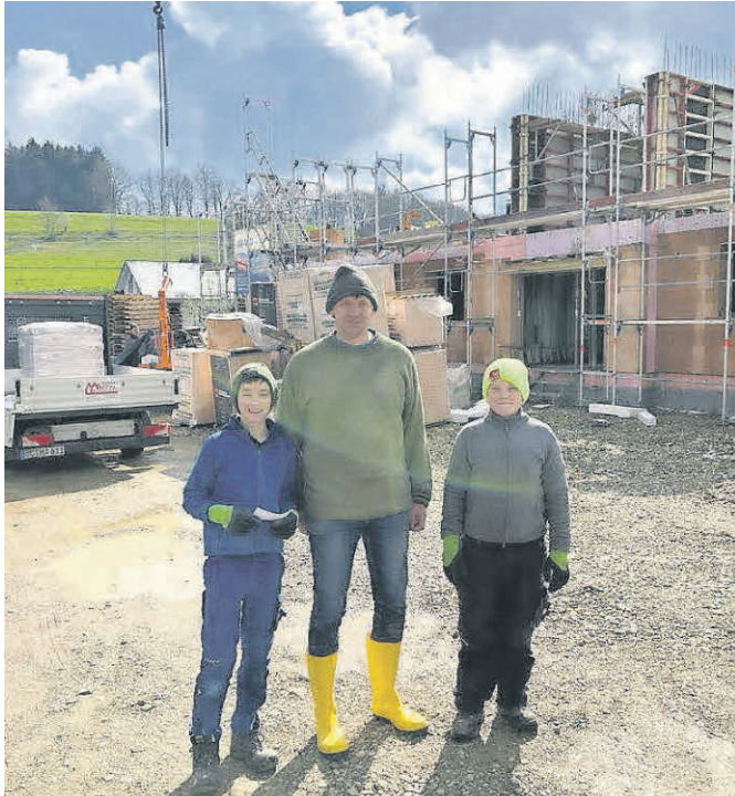
Fabian und Simon arbeiteten bei der Fa. Martin den ganzen Tag auf der Baustelle mit.
