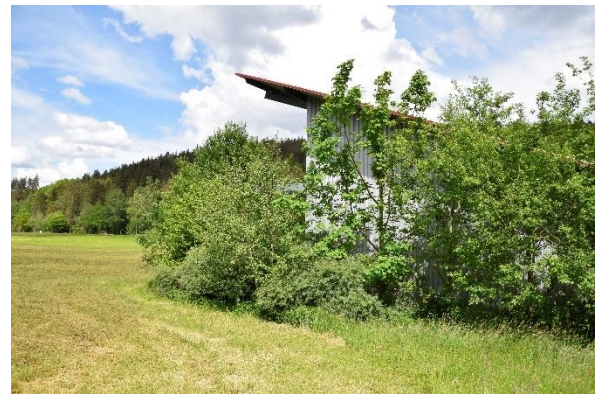
Abbildung 5: Bestandsgebäude (bleibt erhalten) mit vorge-lagerten Gehölzen
