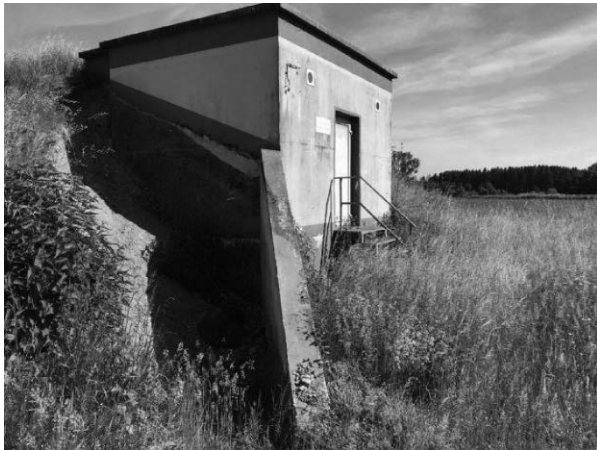
Abbruch Hochbehälter Bärenschachen: 28.418,96 €
