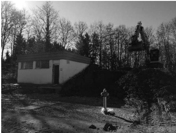
Abbruch Hochbehälter Jägerhaus: 35.595,84 €
